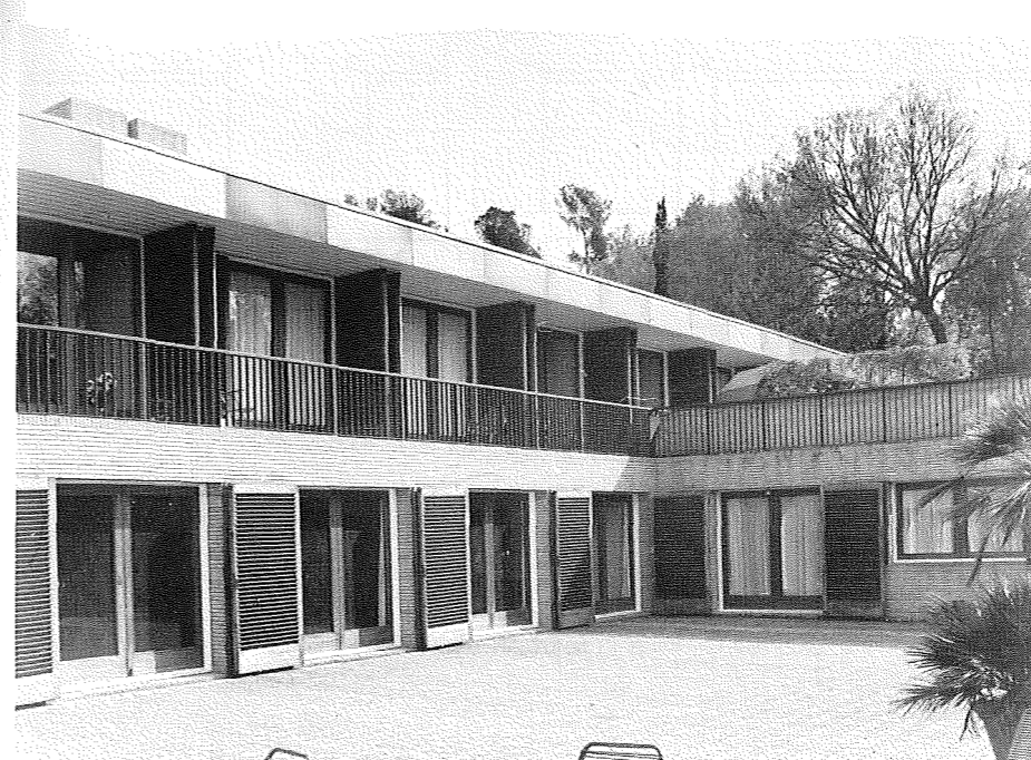
Figur 24. Værelsesfløjen i Det danske Institut i Rom. Værelserne ligger i overetagen med adgang til altan. Som følge af det kuperede terræn er der en etage under terrassens niveau, således at overetagen er 3. etage. Det fælles opholdsrum (festsalen) ligger på 2. etage i venstre side af billedet, med adgang direkte til terrassen. Foto: Skriver.
